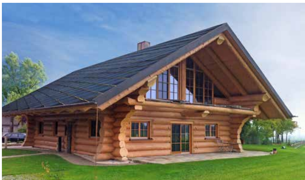
Lauze, ardoise, tuile... la seule constante et la planéité : l'ondulation des tuiles classique générerait des masques solaires qui réduiraient le rendement de la production.
