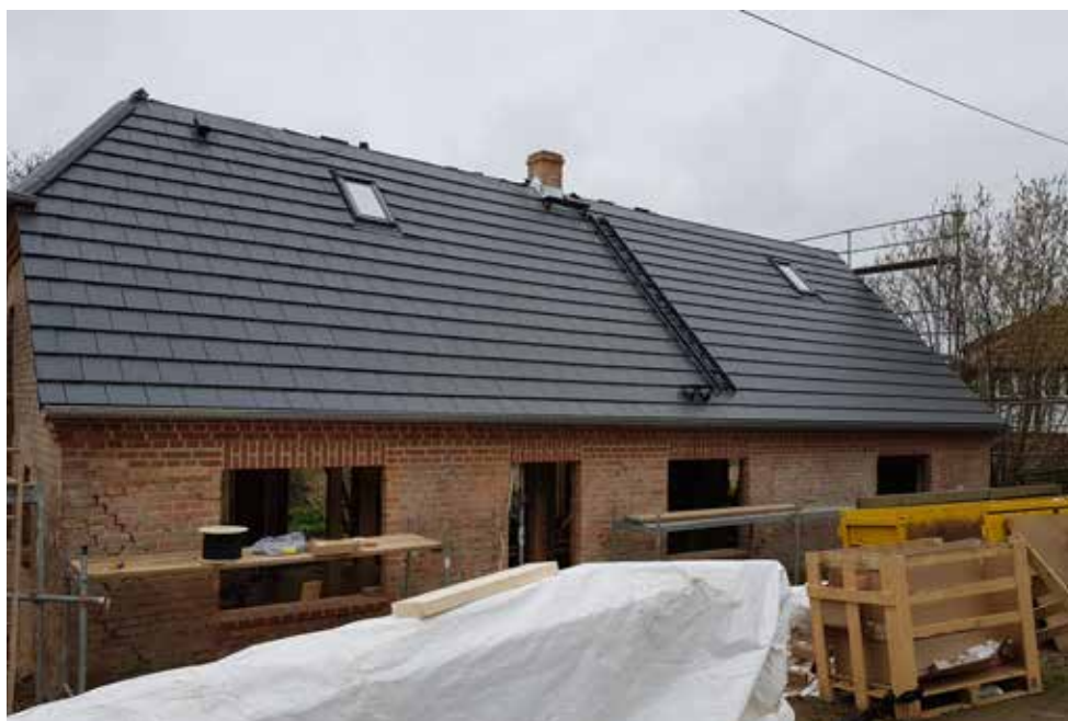
Lauze, ardoise, tuile... la seule constante et la planéité : l'ondulation des tuiles classique générerait des masques solaires qui réduiraient le rendement de la production.
