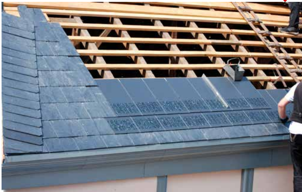
De loin, impossible de distinguer l'ardoise de la tuile photovoltaïque : un gage d'intégration.
